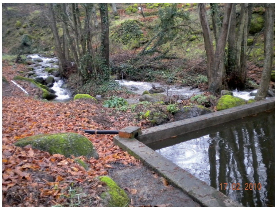
Figure 38 : état des infrastructures d'irrigation dans la vallée du Jerte
