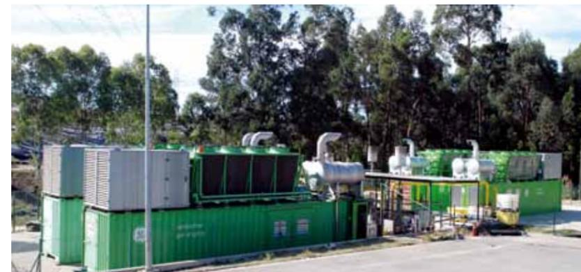
*Vila Nova de Gaia. Aprovechamiento de biogás procedente de vertedero en la producción de energía eléctrica y térmica en las instalaciones de Suldouro*
