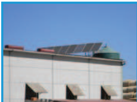
Fig. 5 y 6: Módulos fotovoltaicos y vasos de acumulación.
