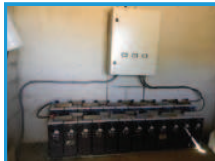
Fig. 5 y 6: Módulos fotovoltaicos y vasos de acumulación.
