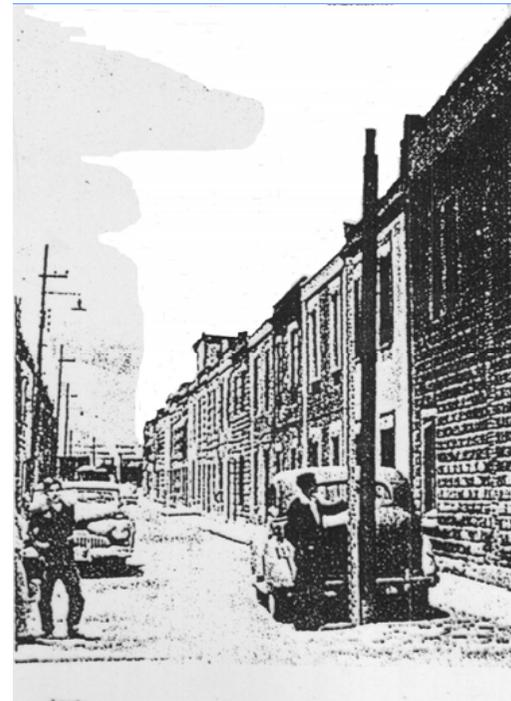
FIG. 6. Tubage de puits mis à nu par l'affaissement du sol dans la partie nord de Mexico.
