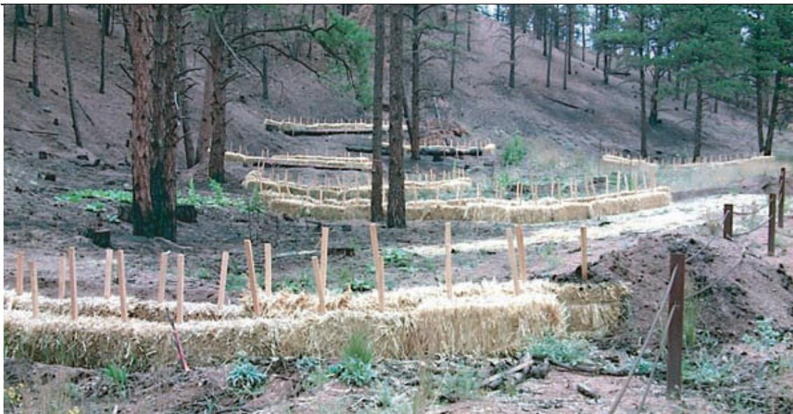
**Figura 15 - Aplicação de estruturas de transversais de retenção com fardos de palha, no incêndio de Hayman, Colorado, EUA. Fonte: Robichaud, 2010.**
