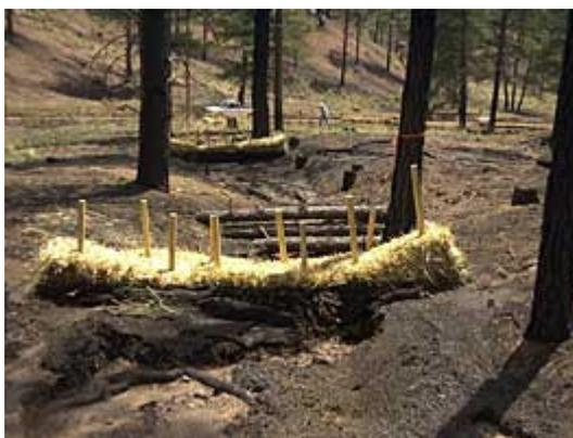
**Figura 16 - Barreira de retenção de sedimentos numa linha de água, constituída por fardos de palha e troncos. Fonte: Land Stewardship Associates LLC,**
