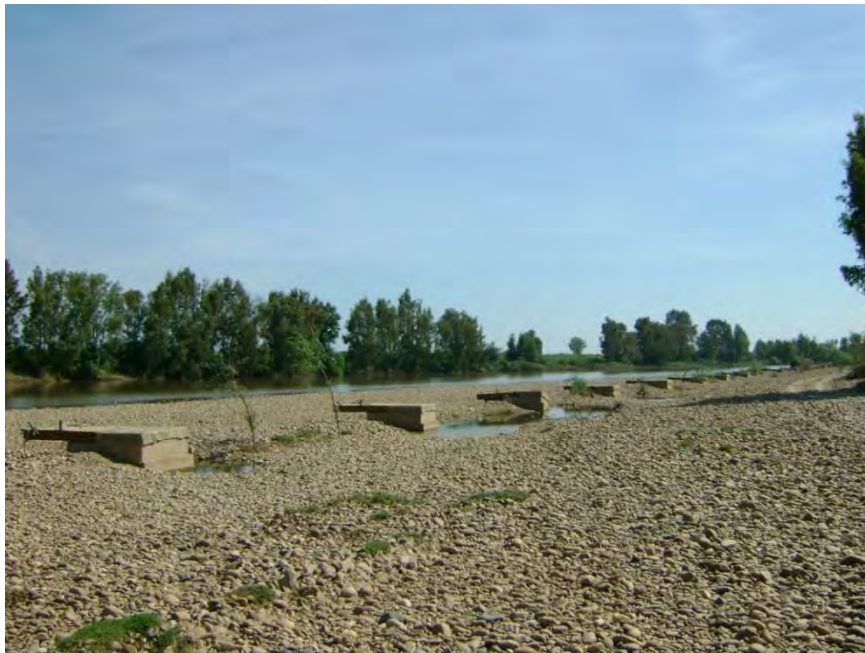
Figura 14. Fotografía del tramo 3 que muestra los diferentes pesquiles ubicados en la orilla. Fuente: Depaex
