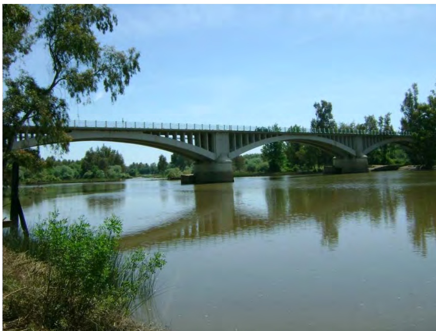
Figura 105. Fotografía del puente de Lobón. Fuente: Depaex.
