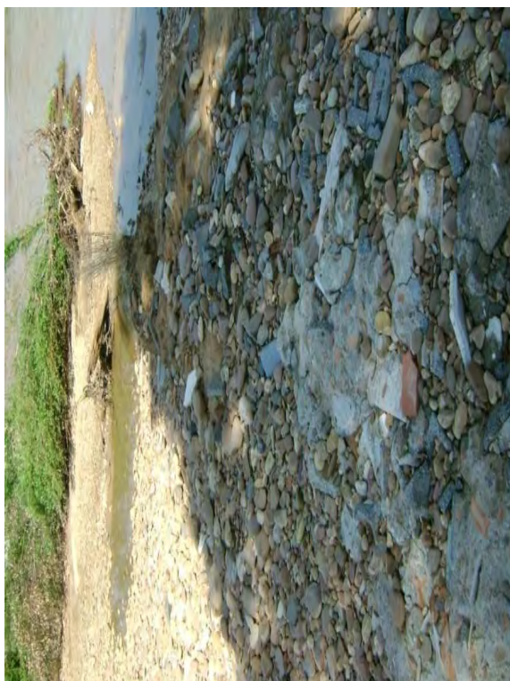
Figura 30. Manchas de cemento y ladrillo, posibles restos del azud. Fuente: Depaex
