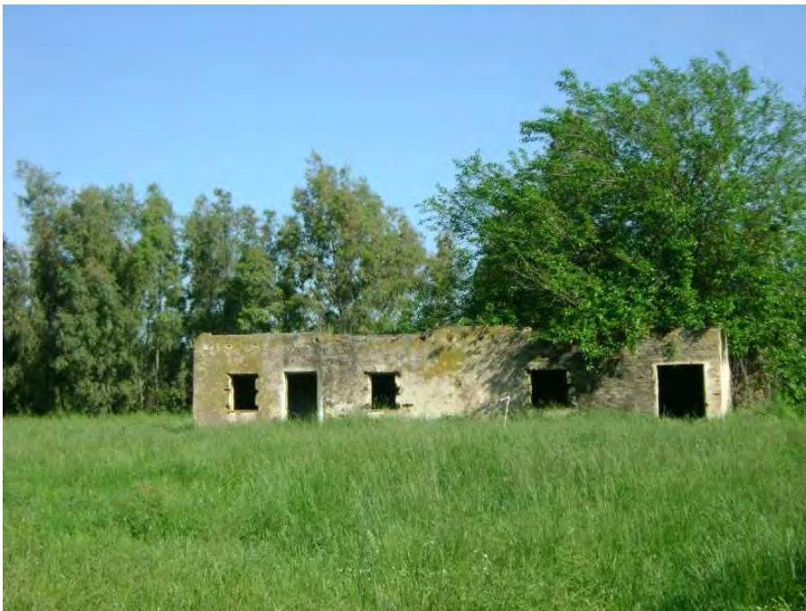
Figura 12. Fotografía del tramo 2 que muestra edificaciones abandonadas en zonas aledañas al río. Fuente: Depaex
