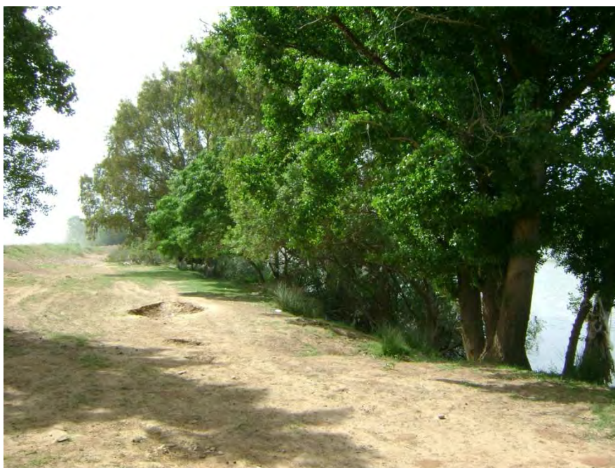
Figura 85. Fotografía del tramo 26 en el que se pone de manifiesto el desnivel existente entre ribera y campos adyacentes. Fuente: Depaex
