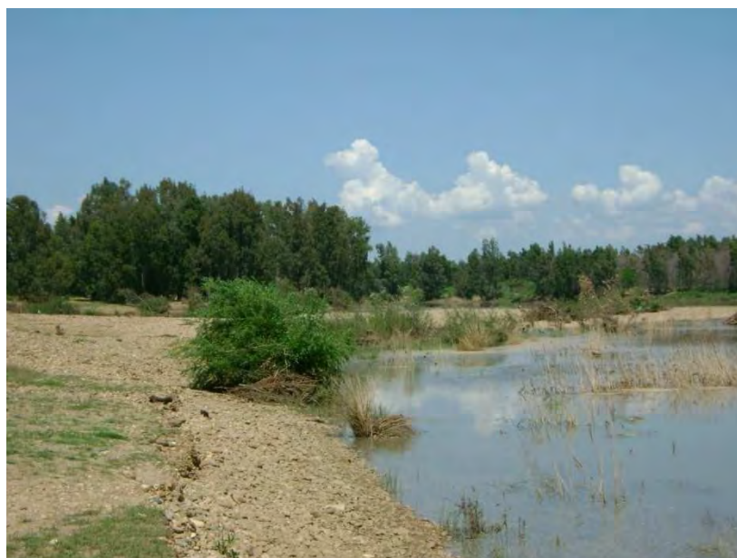
Figura 45. Fotografía del tramo 13, con un primer plano de las orillas, en las que se puede ver signos de erosión. Fuente: Depaex
