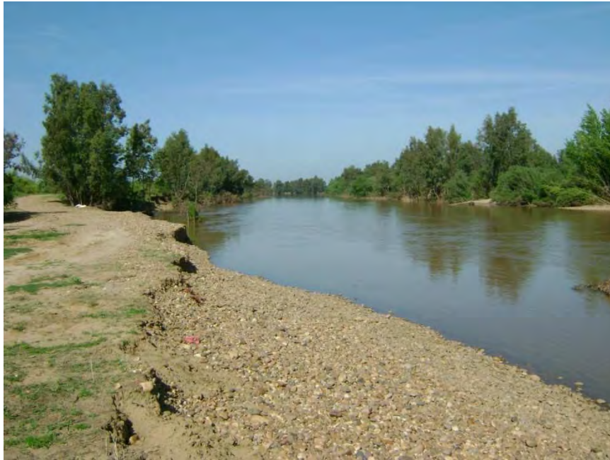
Figura 17. Fotografía del tramo 4 que muestra signos de erosión en la orilla. Fuente: Depaex
