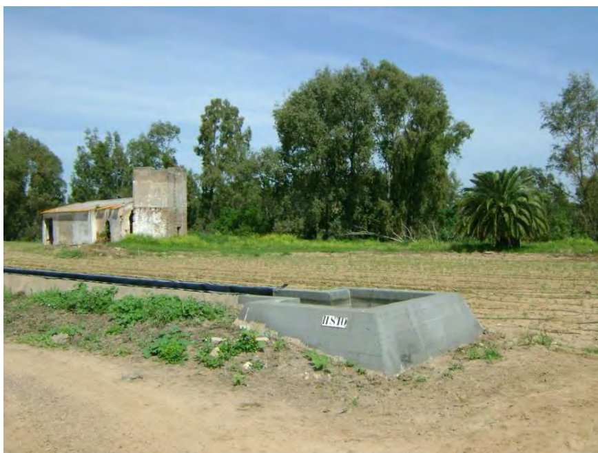
Figura 23. Fotografía del tramo 6 con una caseta al fondo. En un primer plano se puede ver un canal de riego con un reforzamiento plástico en su interior para evitar fugas de agua. Fuente: Depaex
